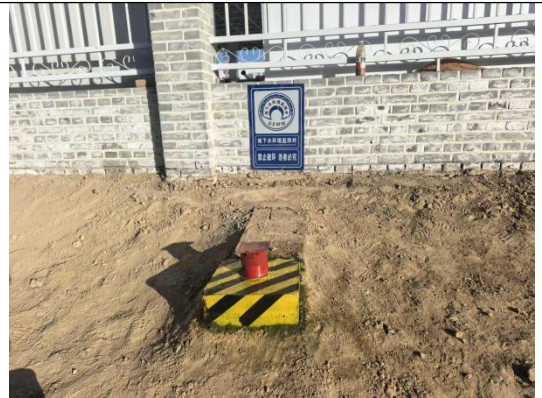
地下水监控井
