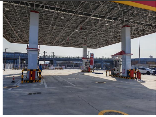
建成后的罐区及加油区
