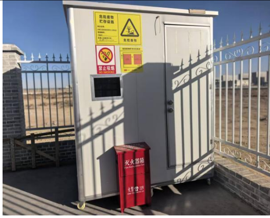
危废暂存点外部照片
