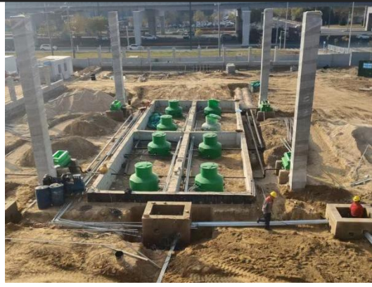
抗渗混凝土防渗罐池建设
