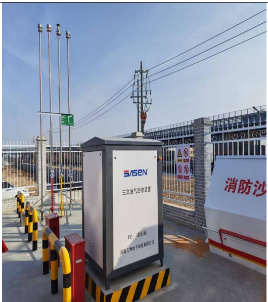
排气筒及储罐泄压阀
