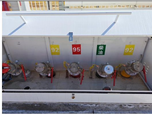
卸油口抗渗混凝土防渗
