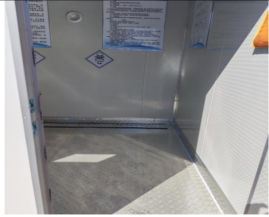
危废暂存点内部照片
