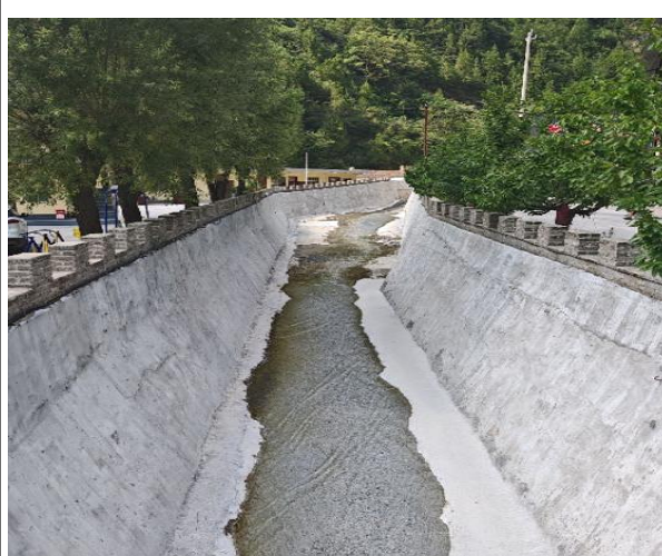
厂区排洪渠道
