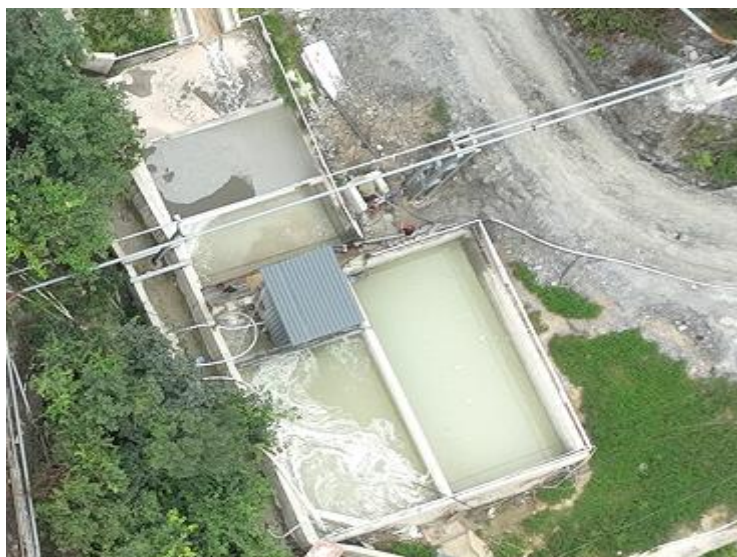
尾矿库坝外三级沉淀池
