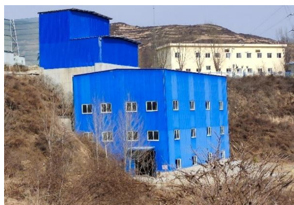
封闭原矿仓和破碎车间
