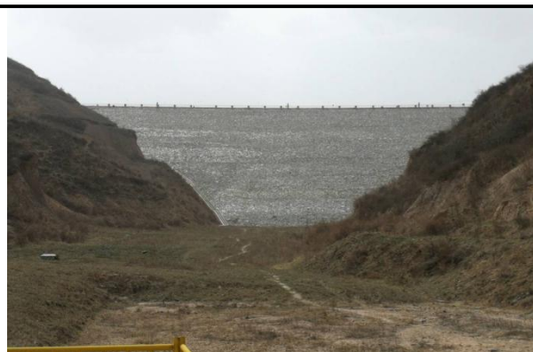
尾矿库初期坝
