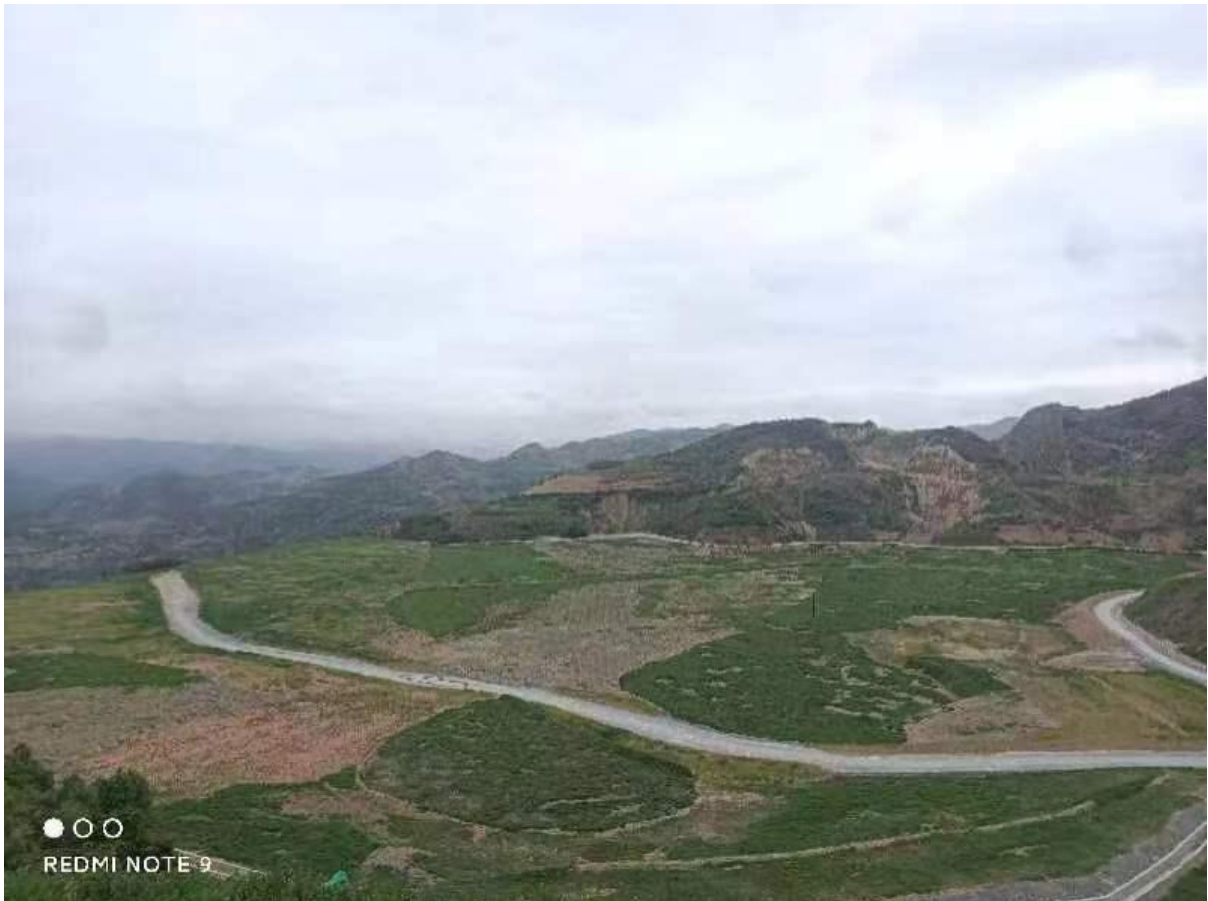
麻地沟排土场恢复现状图
