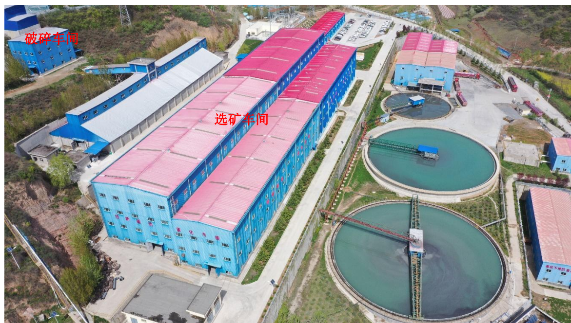
选矿厂整体封闭建设现状
