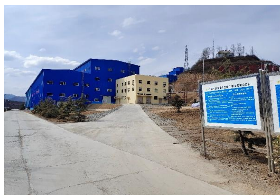
封闭磨浮车间
